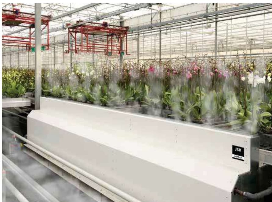
Door onder de tafels te ventileren, heeft de teler minder narigheid in de kas, kan hij dichter op het gewas koelen en hoeft hij minder te schermen.
